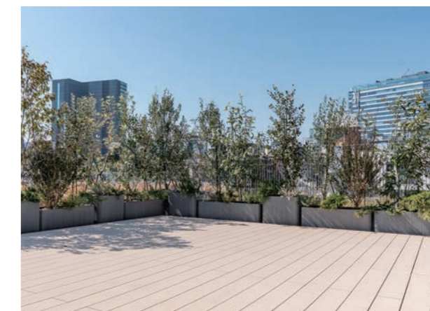
CASE 3 GRC プランター KG をランダムに配置した 屋上緑化事例
