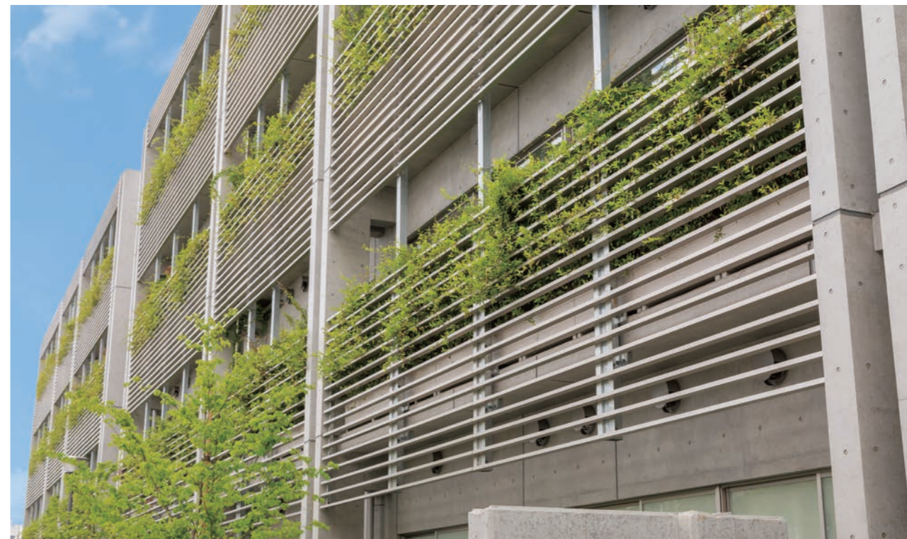
CASE 1 FRP 連結プランター KG による壁面緑化で、無機質な外観デザインに緑の演出。
